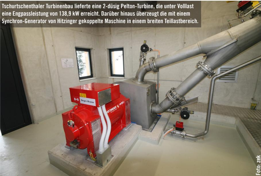
Das Triebwasser schießt mit knapp 12 bar Druck auf die Pelton-Becher des Laufrads.
