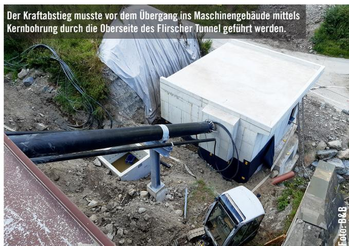
Der Kraftabstieg musste vor dem Übergang ins Maschinengebäude mittels Kernbohrung durch die Oberseite des Flirscher Tunnel geführt werden.
