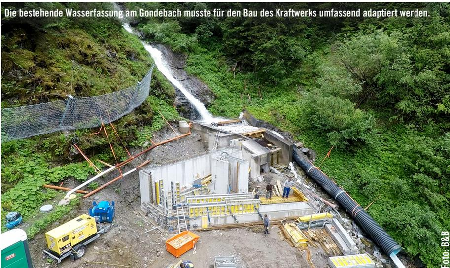
Die bestehende Wasserfassung am Gondebach musste für den Bau des Kraftwerks umfassend adaptiert werden.
