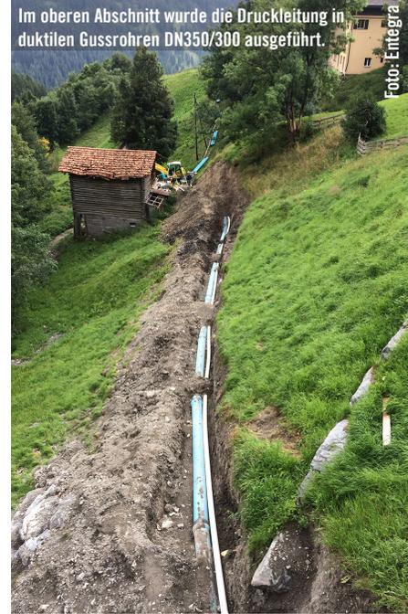
Im oberen Abschnitt wurde die Druckleitung in duktilen Gussrohren DN350/300 ausgeführt.
