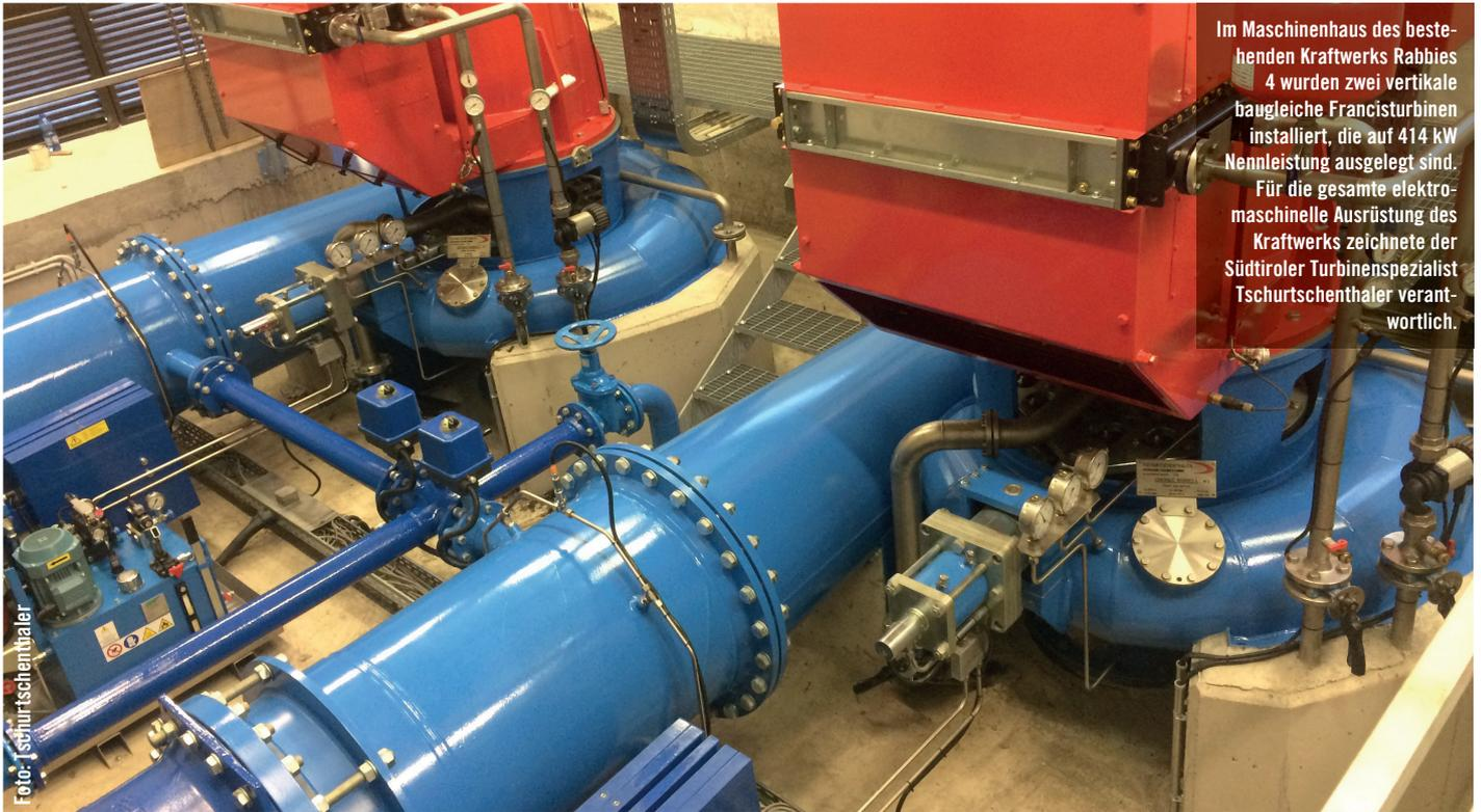
Im Maschinenhaus des bestehenden Kraftwerks Rabbies 4 wurden zwei vertikale baugleiche Francis-Turbinen installiert, die auf 414 kW Nennleistung ausgelegt sind. Für die gesamte elektromaschinelle Ausrüstung des Kraftwerks zeichnete der Südtiroler Turbinenspezialist Tschurtschenthaler verantwortlich.
