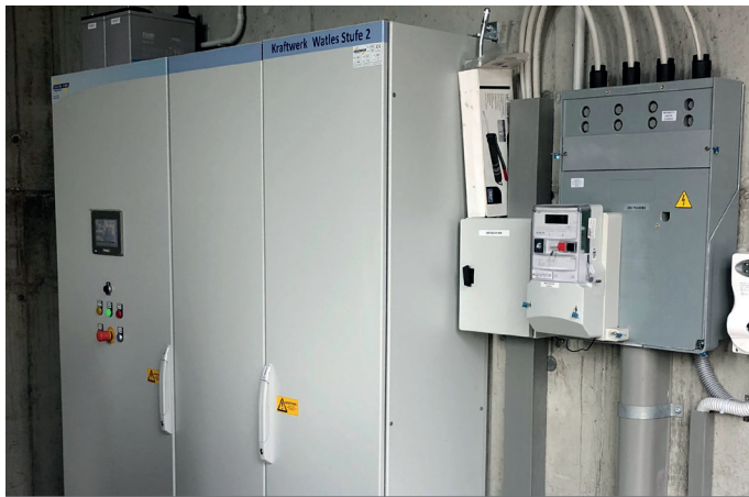
Die gesamte Steuerungs- und E-Technik für die beiden Kraftwerke wurde von Electro Clara ins übergeordnete Leitsystem für Beschneidung und Bewässerung eingebunden. Die Steuerung stellt sich bei den Anlagen insofern außergewöhnlich dar, als beide Turbinen über den Pegel in ihrem jeweiligen Unterwasser geregelt werden.
