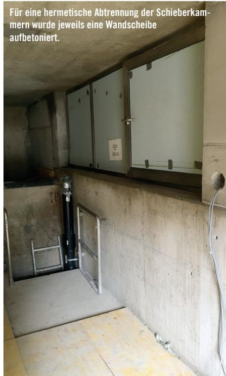
Für eine hermetische Abtrennung der Schieberkammern wurde jeweils eine Wandscheibe aufbetoniert.
