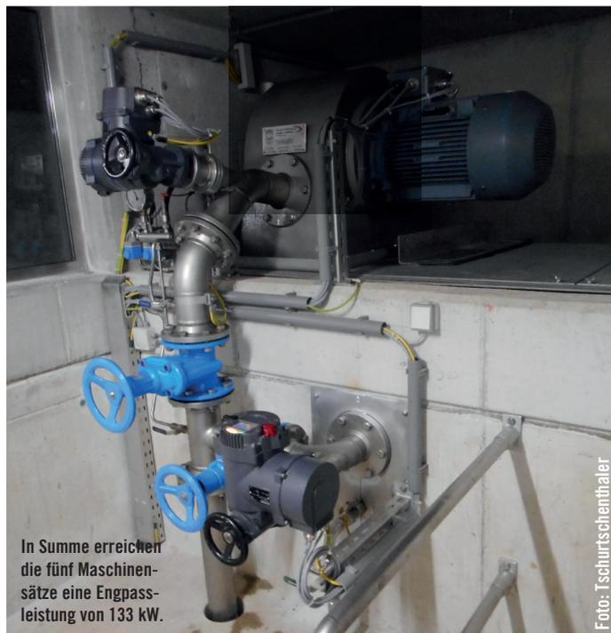
In Summe erreichen die fünf Maschinensätze eine Engpassleistung von 133 kW.
