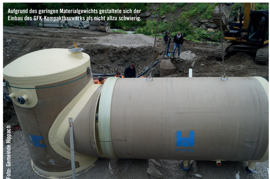
Aufgrund des geringen Materialgewichts gestaltete sich der Einbau des GFK-Kompaktbauwerks als nicht allzu schwierig.
