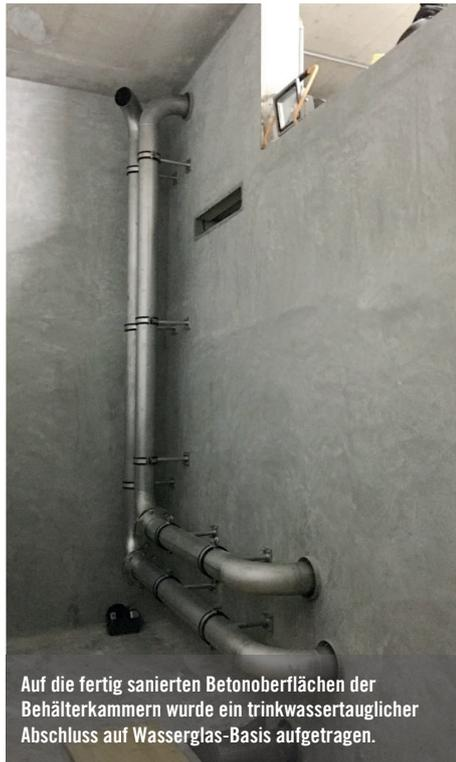
Auf die fertig sanierten Betonoberflächen der Behälterkammern wurde ein trinkwassertauglicher Abschluss auf Wasserglas-Basis aufgetragen.
