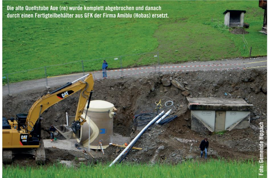
Die alte Quellstube Aue (re) wurde komplett abgebrochen und danach durch einen Fertigteilbehälter aus GFK der Firma Amiblu (Hobas) ersetzt.
