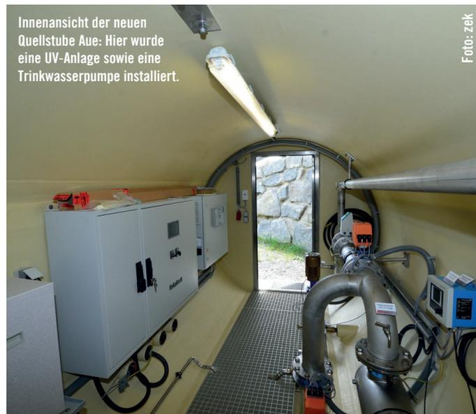
Innenansicht der neuen Quellstube Aue: Hier wurde eine UV-Anlage sowie eine Trinkwasserpumpe installiert.
